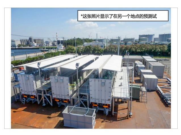
**福岛第一核电站**放射性污染油水混合物处理设施现已成功投入运行。人们采用DiaCCon的金刚石电极进行清除(高级氧化)。
